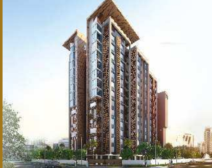
RWD Corniche, Egmore
